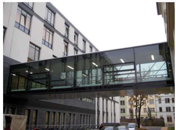
Neubau VERBINDUNGSBRÜCKEN / GLASDACH/-FASSADE KHDF KRANKENHAUS DRESDEN-FRIEDRICHSTADT
